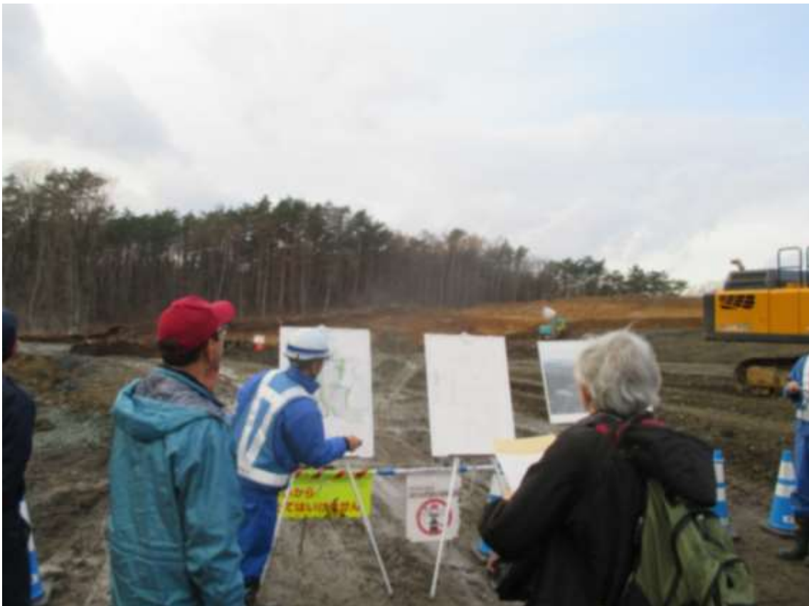
軽米尊坊太陽光発電所
