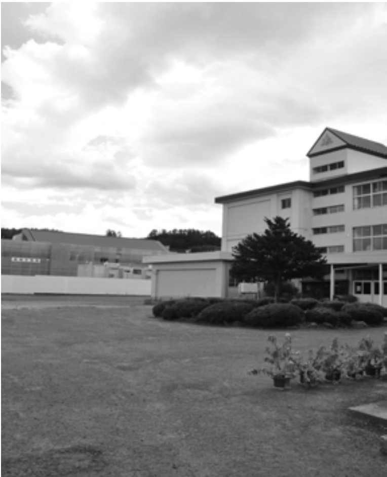
建設が進む軽米小学校（左奥が新たな校舎）
