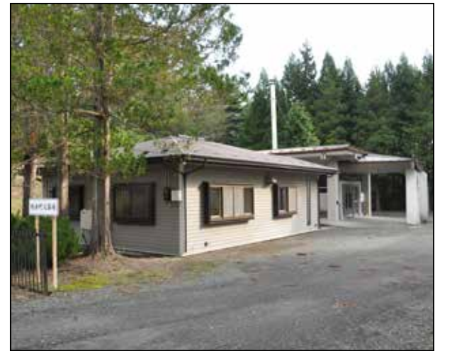
設置から40年が経過した町火葬場（写真中央が待合室）
