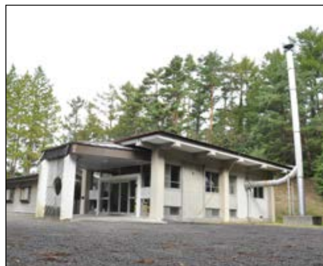
建築から41年が経過し、交換・修理をしながら使われ続けている町火葬場
