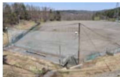
県道二戸軽米線から見た町営第2野球場
