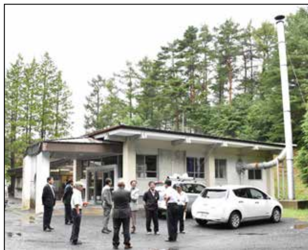
平成 30 年度以降、大規模な施設整備が計画されています（写真は、31 年度の更新をめざす町火葬場）
