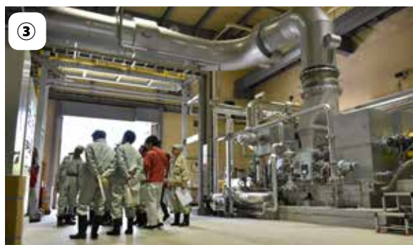
①一部には太陽光発電パネルの設置が進む西ソーラー ②八戸自動車道・折爪 SA の西側付近の現場 ③バイオマス発電所のタービンを視察
