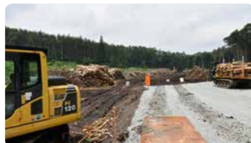
伐採作業が進められる軽米尊坊ソーラー新設工事(調査日時点の様子)
