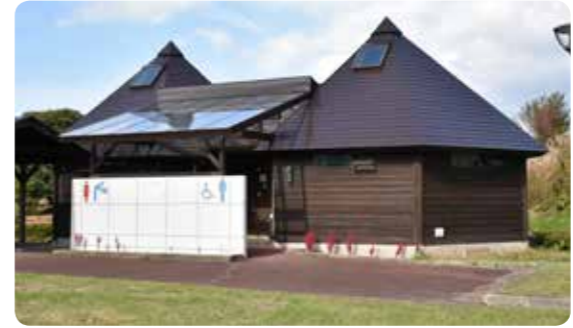
設備更新や塗装などが施され利便性が向上したミル・みるハウスの屋外トイレ
