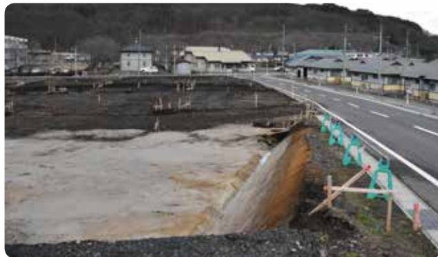
町営新萩田2号住宅（仮称）の造成工事が行われる旧県北農業試験場跡地
