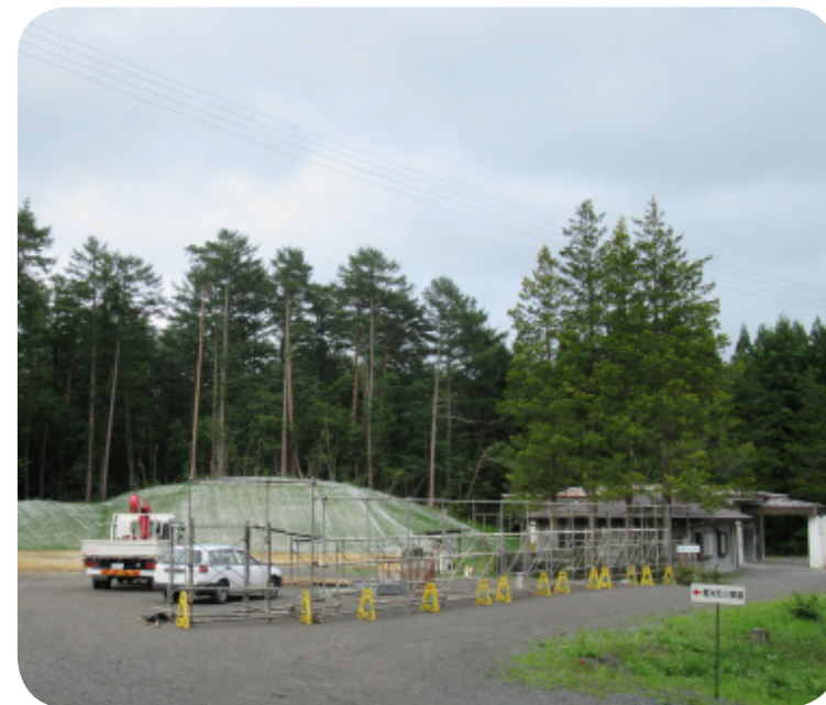
写真は、令和2年4月の供用開始に向けて工事中の町火葬場の様子
