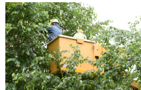
高く手が届かないところは高所作業車の作業をお願いしました
