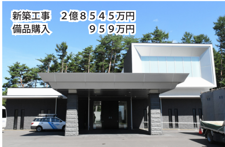
旧火葬場は、解体工事が行われています（写真はかるまい斎苑）
