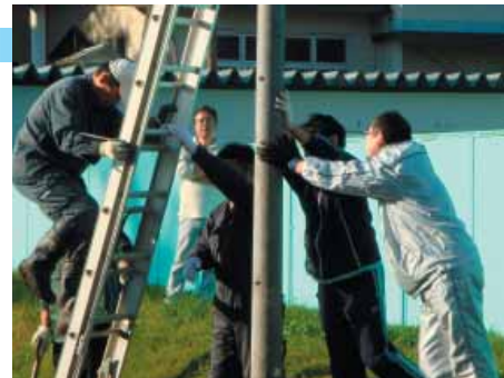
倒壊した柱の撤去から、新たな柱の掘削、設置まで無事に完了しました
