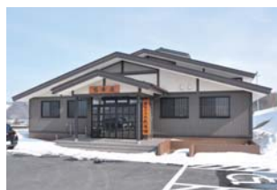
完成した軽米中学校武道場
