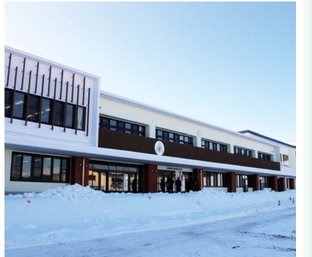
完成した軽米小学校新校舎
