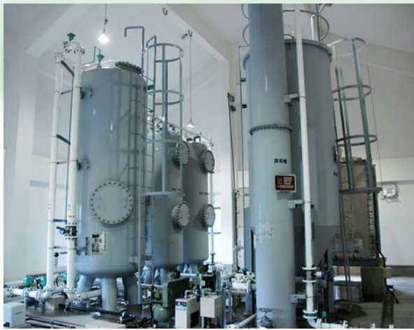
完成した笹渡簡易水道
