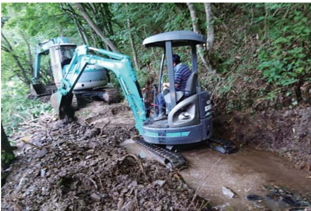
重機を使っての道路の開通作業
