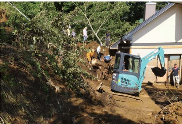
重機を使っての土砂撤去
