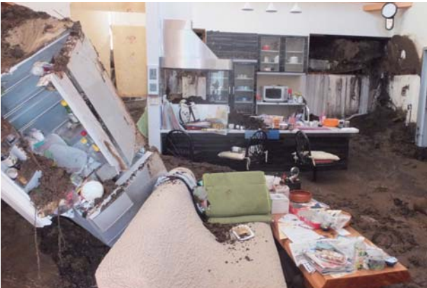
家屋への土砂流入①
