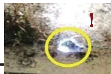
壁や床の破損がないか （外の光が漏れている 所は要注意）
