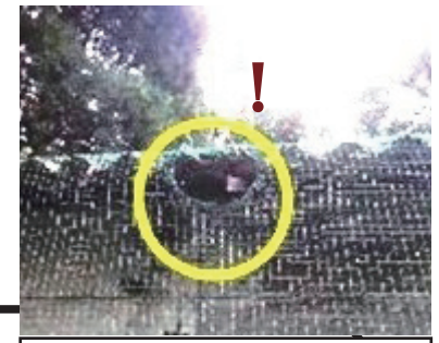
防鳥ネットの破れがないか
