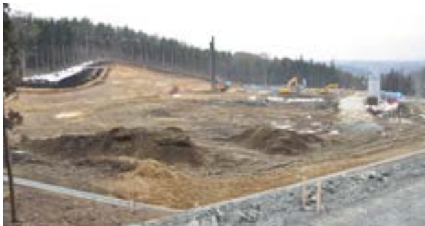
20人以上の雇用が見込まれる鶏糞バイオマス発電施設（晴山地区）の建設工事は現在造成工事が進められています
