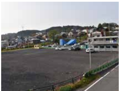
町役場駐車場(写真)では庁舎等地中熱暖房システムと太陽光発電設備の工事が進められています(10 月撮影)
