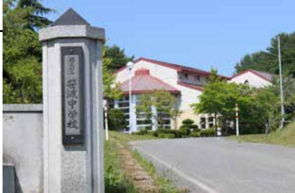
閉校校舎やグラウンドなどを地域づくりに生かす方策が求められています（写真は旧笹渡小中学校）
