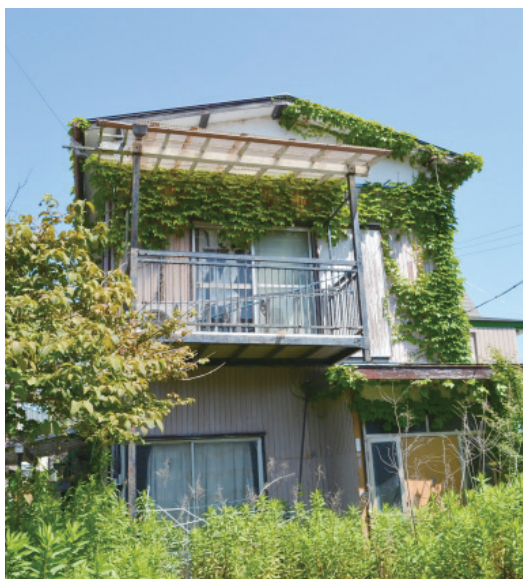
空き家は、倒壊や部材の落下、害虫や悪臭、近隣トラブルなどさまざまなリスクを引き起こす原因となります（写真はイメージ）
