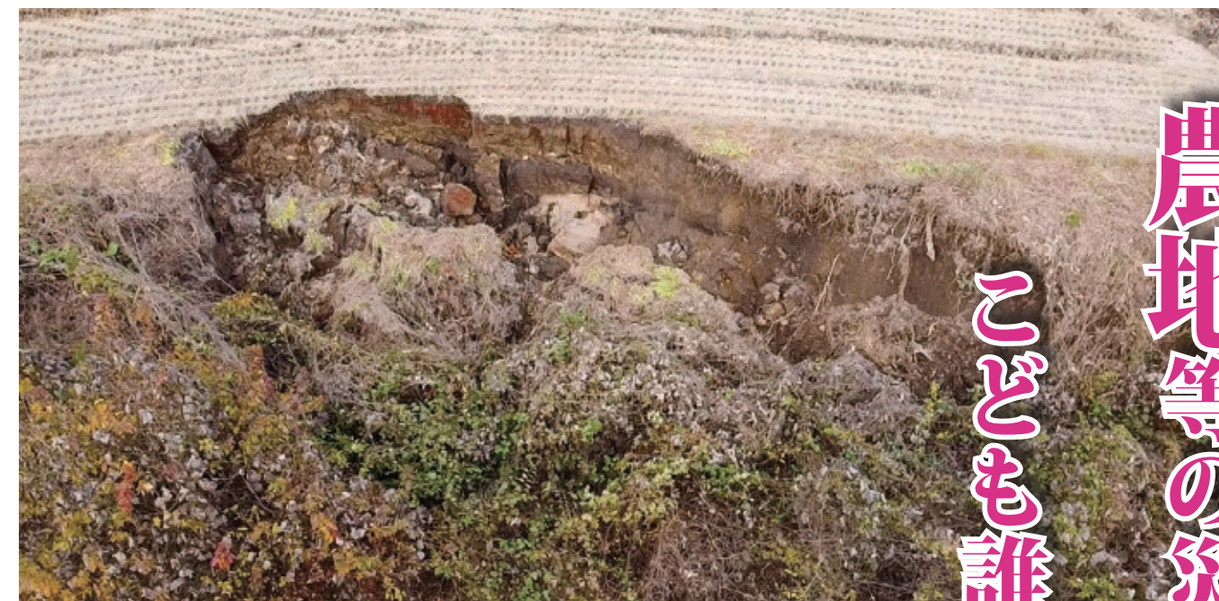
豪雨の影響で崩落した農地法面
