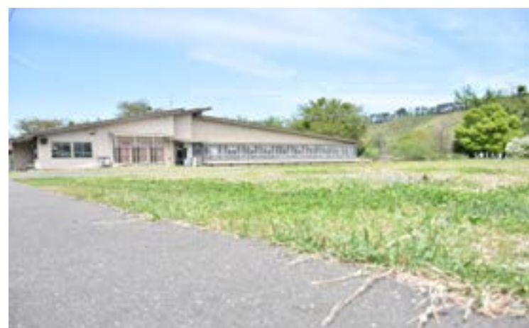
解体予定の青少年ホーム
