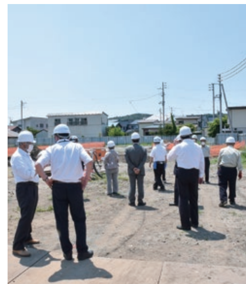
令和3年6月に行った宇漢米館建設工事の現地調査の様子
