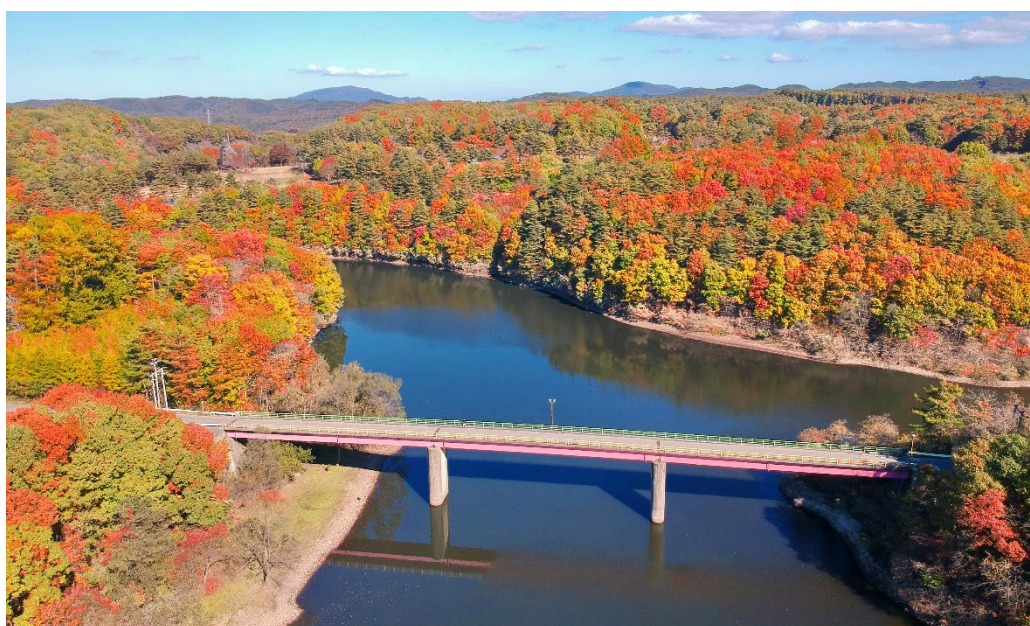
雪谷川ダムに架かる深渡橋(1976年建設)
