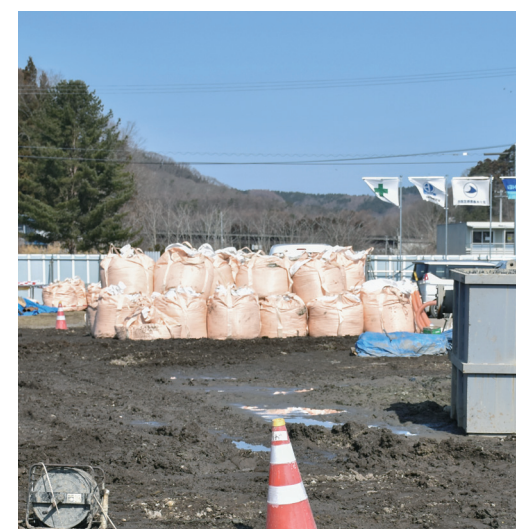
ボーリング工事で出た良質土はトン袋に入れ再利用、コンクリート殻は処理されました
