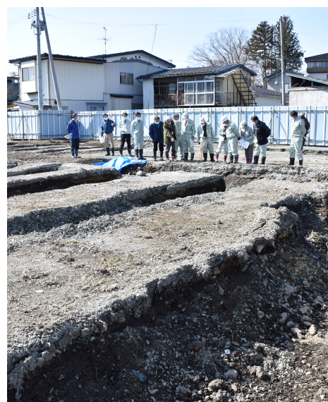
交流駅の建設工事は5か月から7か月の遅れとなります(写真は令和3年3月実施の現地視察)
