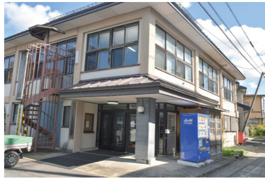
軽米中央公民館の老朽化が進んでいる
