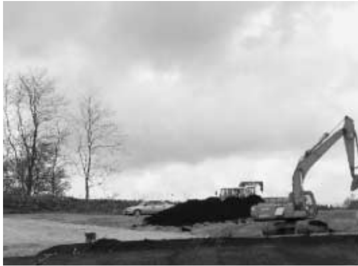
統合晴山小学校（仮称）造成工事
