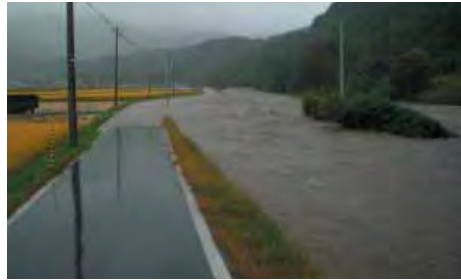
▲瀨月内川（写真右）の増水で冠水した町道平・堰ノ下・新井田線（大清水地区）
