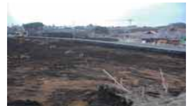
平成22年度の開校に向けて造成工事が進められる晴山小学校（写真右はミル・みるハウス）
